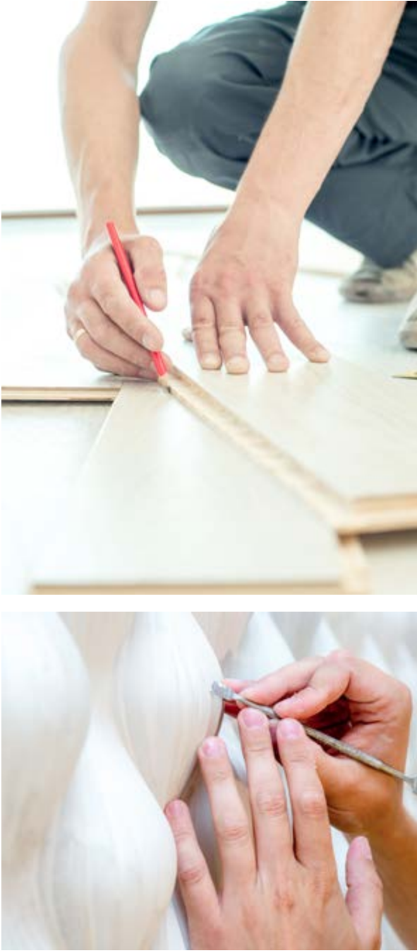
Комплексный ремонт осуществляется в строгом соответствии с проектной документацией, которая включает договор подряда, смету на ремонтно-отделочные работы, график производства работ и финансирования.
